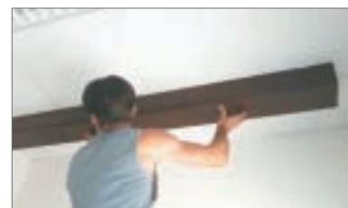
Posizionare la trave al soffitto
