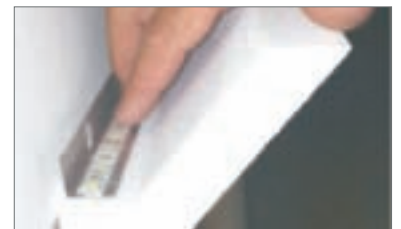
Fissare la striscia Led alla guida
