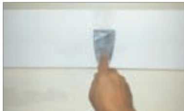
8 - Stuccare il giunto con spatolina
