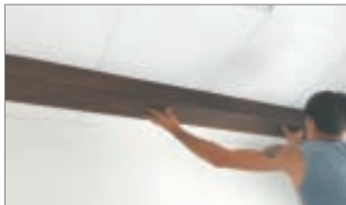
4 - Posizionare la trave tra le guide
