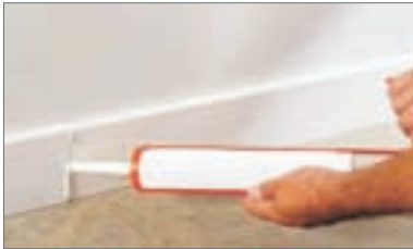
4 - Avvicinare le cornici e riempire con colla MS180 lasciando almeno mm2
