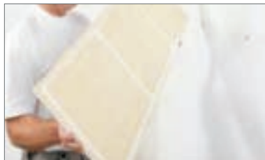
2 - Dopo aver segnato una linea a livella posizionare i pannelli alla parete
