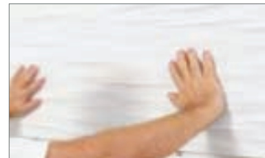
3 - Fare una leggera pressione per far aderire meglio il pannello alla parete
