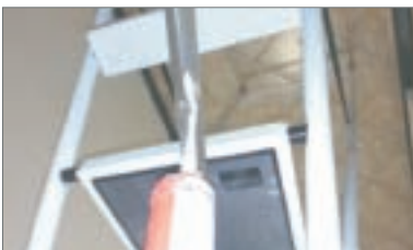
Applicare la colla MS180 sulla guida
