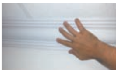
7 - Avvicinare le cornici fino ad unirle ed eliminare il collante in eccesso
