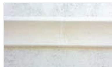
15 - Eseguire la stuccatura di tutti i giunti
