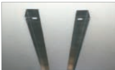
2 - Distanziarle in base alla misura interna delle travi da posare
