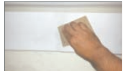
9 - Carteggiare per rendere la superficie liscia e pronta da tinteggiare
