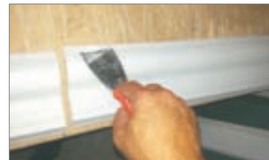
3 - Oppure applicare la colla Get - Kol con spatolina
