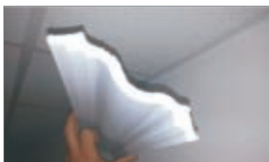
4 - Applicare la cornice alla parete
