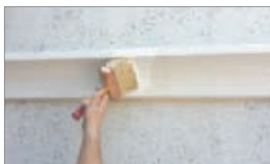
17 - Eseguendo due mani di pittura
