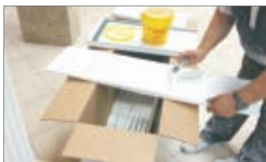
1 - Applicare la Colla MS180 o Get Kol sul retro del pannello
